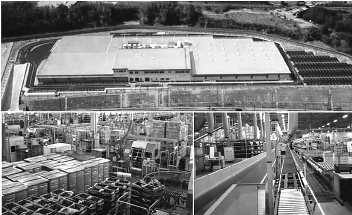
โรงงานคัดแยกสินค้าของสหกรณ์ http://www.daifuku-logisticssolutions.com/jp/
